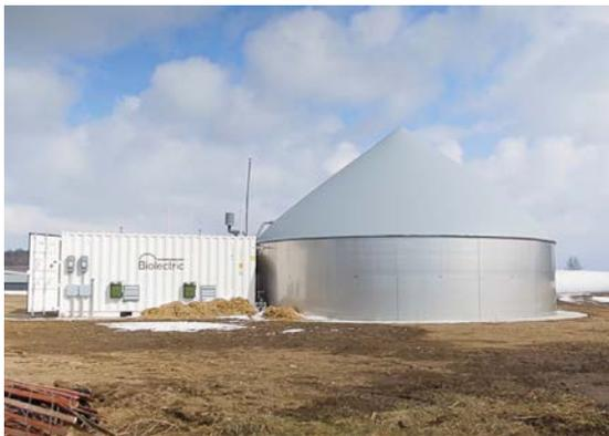
**SMALL-SCALE ANAEROBIC DIGESTER AT HARCOLM FARMS**
